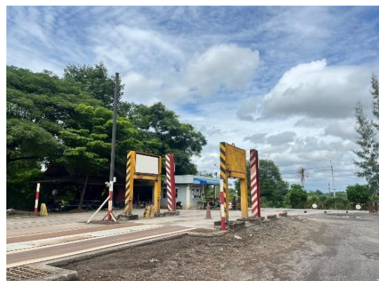
รูปที่ 41 ติดตั้งเครื่องตรวจวัดกัมมันตรังสี (Gate Monitor) บริเวณทางเข้า-ออก
